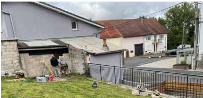
Réfection bardage suite démolition
