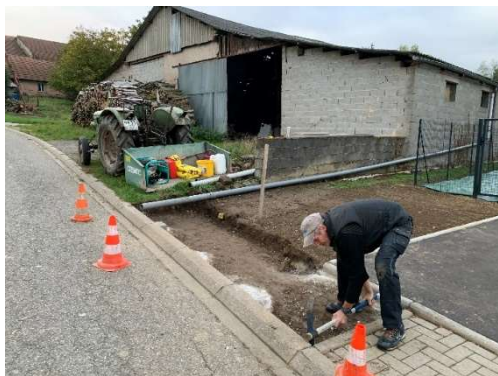
Prolongement d'une partie du trottoir rue de Hangviller
