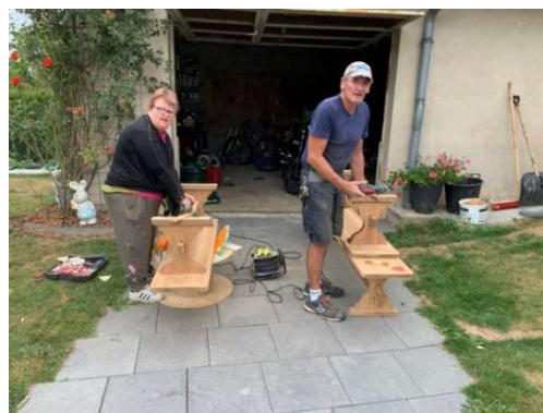
Rénovation des bancs de l'école
